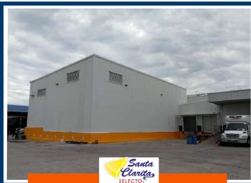
Cámara fría y cuarto de secado Culiacán, Sin.
