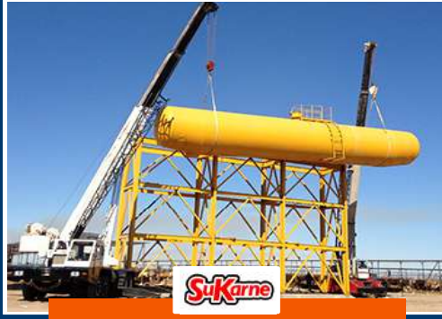
Estructura y tanque para almacenamiento de 125 m3 de agua en planta Mexicali B.C.
