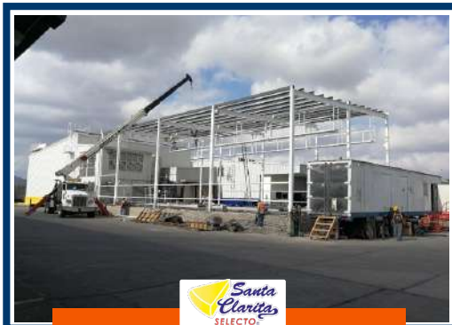
Construcción de cámara fría Culiacán, Sin.
